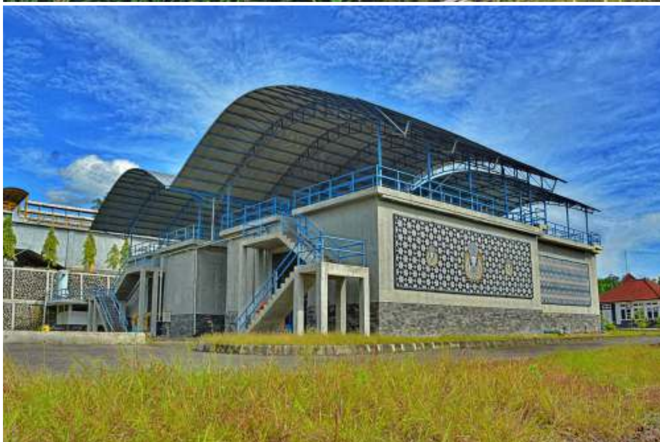
INSTALASI PENGOLAHAN AIR SPAM KARTAMANTUL 400 LITER/DETIK
