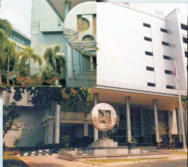
Kementerian Pekerjaan Umum
